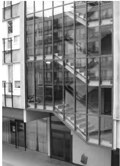
Cage d'escalier en façade.
