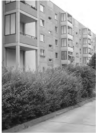
Nouveaux balcons côté cour intérieure.
