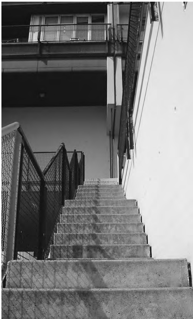
Escalier extérieur de la cité du Pallaseum.
